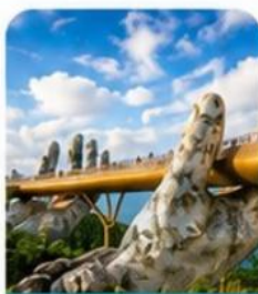
สะพานมือสีทอง
