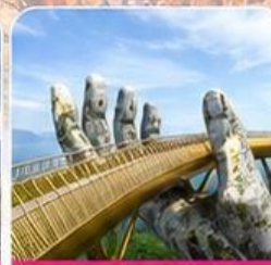
สะพานมือสีทอง
